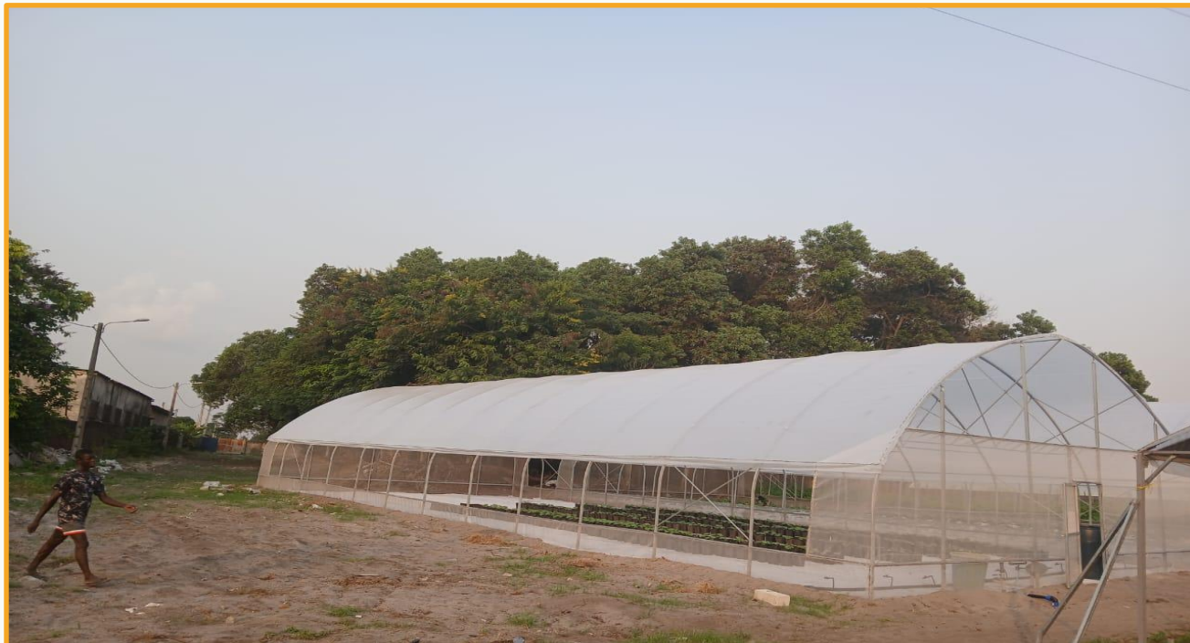
Serre de 250 m 2 à Bingerville
