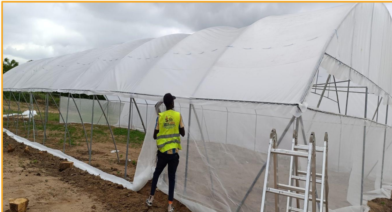
Installation en cours — Serre Ivoire
