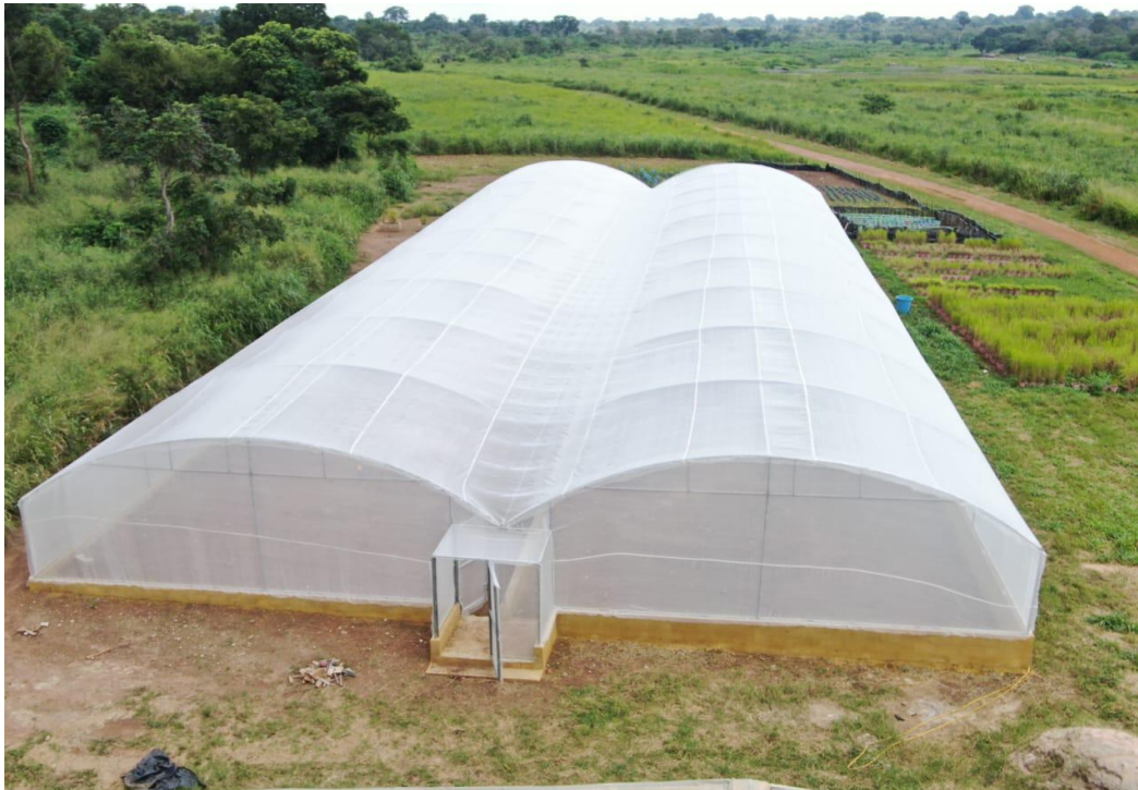
Figure 2: Réalisation du prototype sur le site d' Africa Rice à Bouaké
